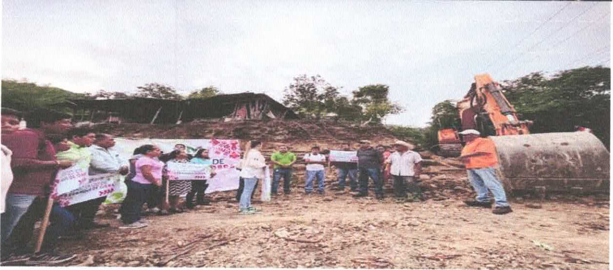
Arranque de obras
